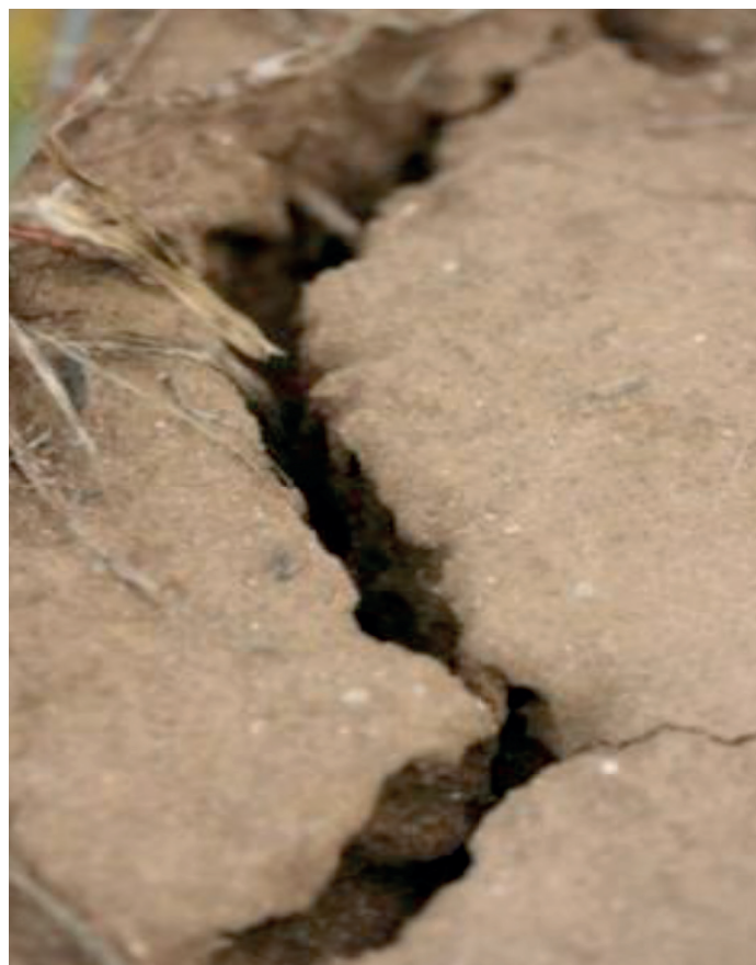
Grietas en un suelo arcilloso
