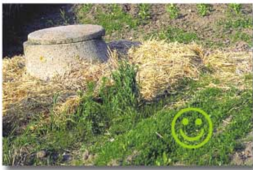
Figura 15. Pozo adecuadamente protegido (foto E. Nilsson - VISAVI)
