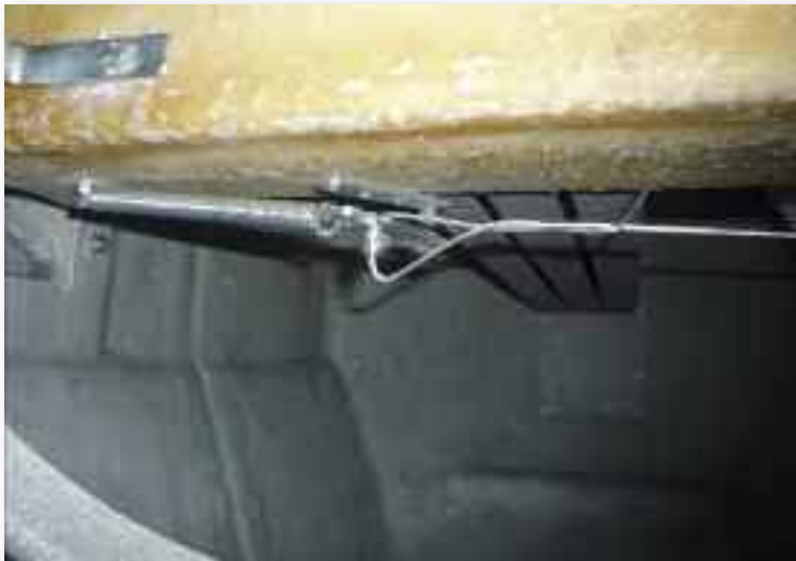
Comprobación del recorrido de la compuerta desviadora de flujo en el interior del depósito
