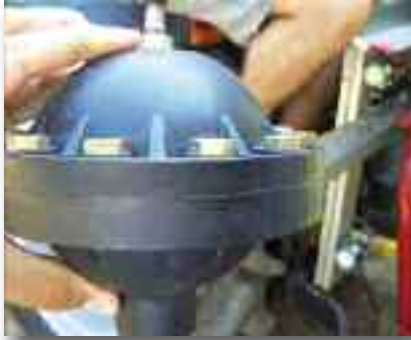
Presencia y presión correcta de los compensadores de presión (calderín)
