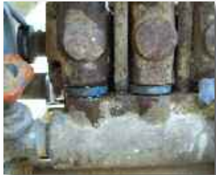
Se detectan fugas en la bomba estando ésta parada o bien en funcionamiento
