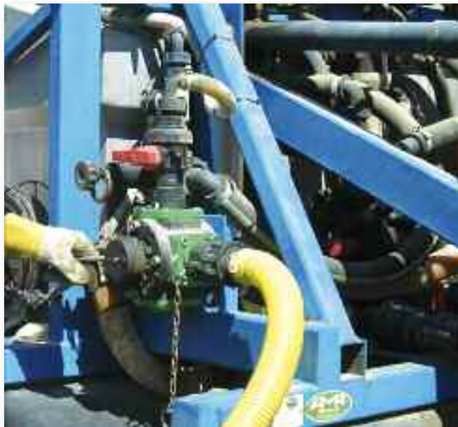
El sistema antirretorno funciona correctamente
